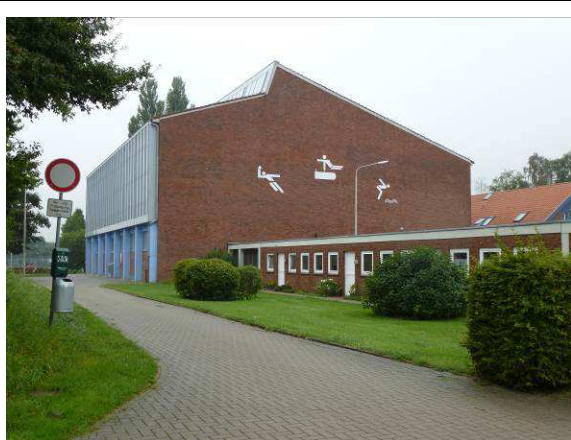
Turn- und Schwimmhalle
