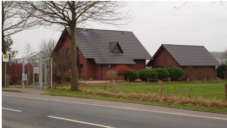
Abb. 5 Wohnbestand im Plangebiet
