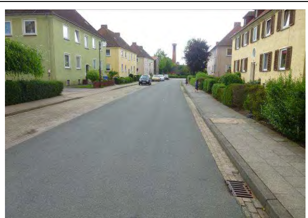
Nebenanlage und Parken - Detmarstraße
