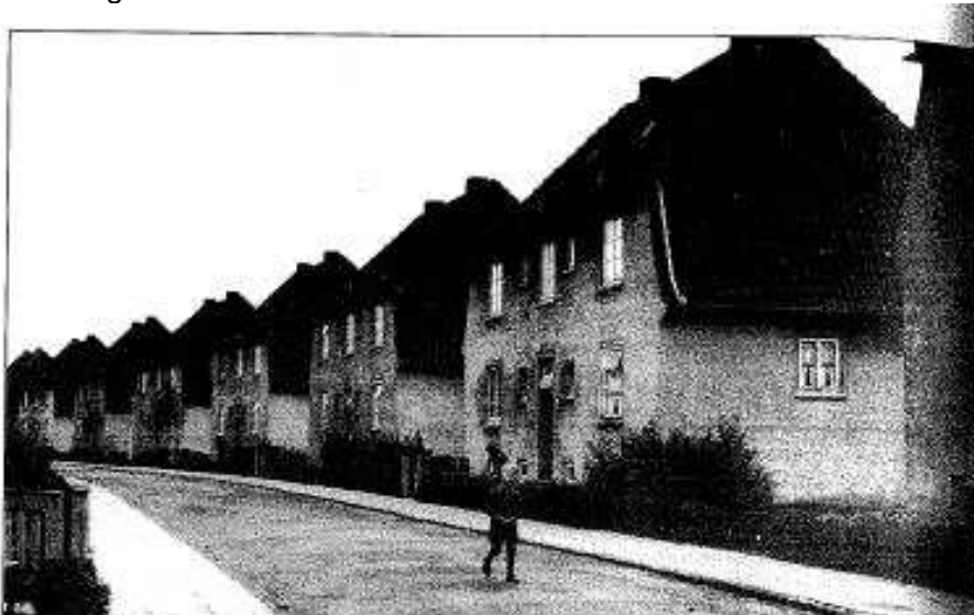
Die Thammstraße mit der Häuserreihe, in der sich die kleinsten Wohnungen befanden
