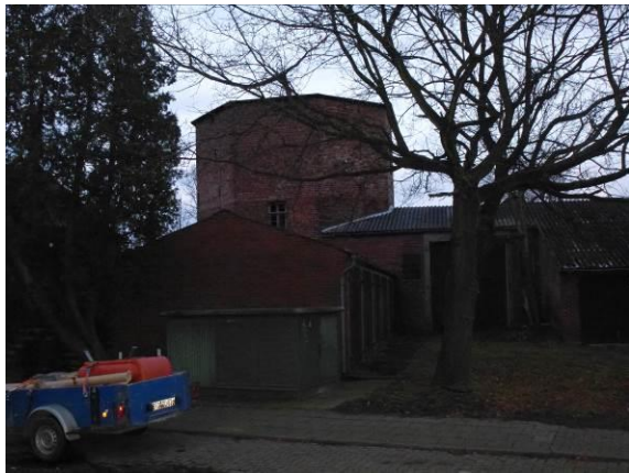
Mühlenfuß, im Vordergrund Garagenhof
