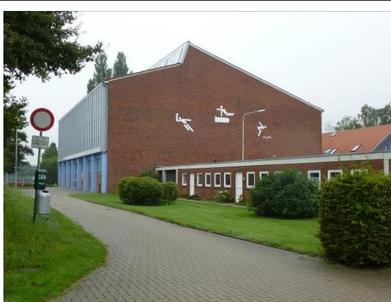
Turn- und Schwimmhalle
