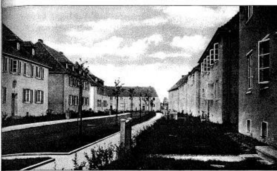
Blick in die Detmarstraße bis zu dem an der Eschhofstraße gelegenen Platz. Die Wohnungen der linksseitig gebauten großen Häuser waren meist an Ingenieure vermietet.
